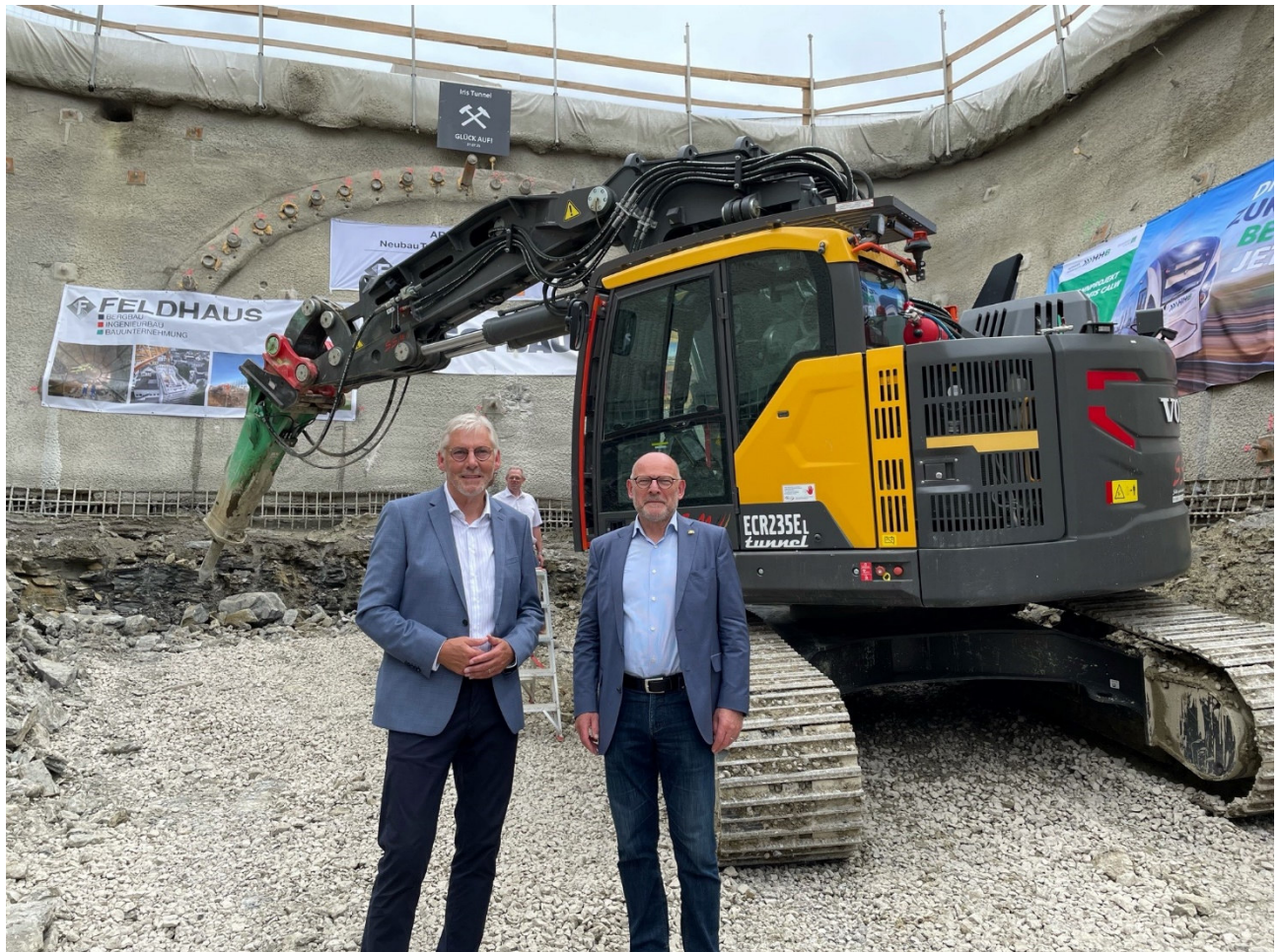
Bildunterschrift: Landrat Helmut Riegger (links) und Verkehrsminister Winfried Hermann (rechts) beim Anstich des Neubautunnels in Ostelsheim am 27.07.2021.
