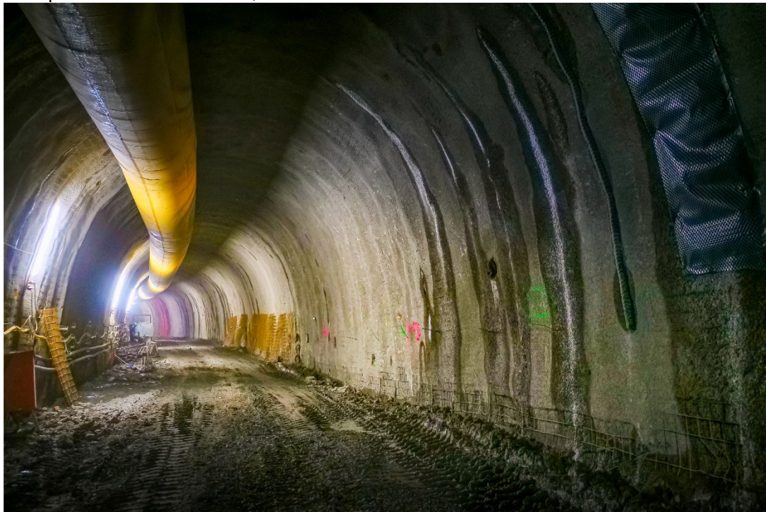
Bildunterschrift: Der Neubautunnel in Ostelsheim ist 498 Meter lang. Bildquelle: Gert Tetzner, avmedia factory.
