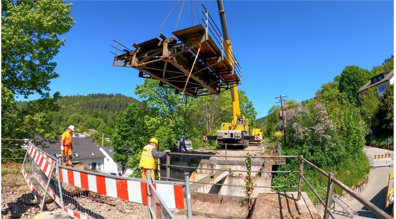
Bildunterschrift: Im Rahmen der vorbereitenden Arbeiten für die Inbetriebnahme der Hermann-Hesse-Bahn wurde kürzlich die Welzbergbrücke ausgebaut. Sie wird nun saniert und kehrt schließlich an ihren alten Platz zurück.
