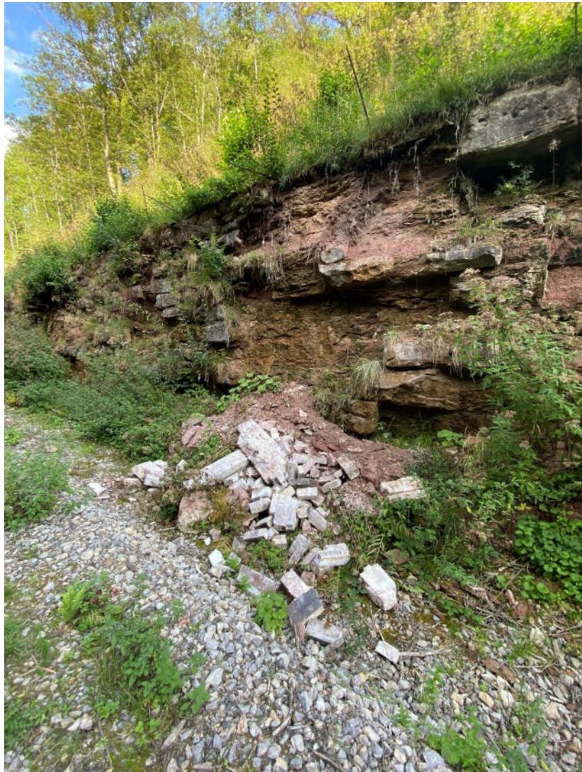
*Abbildung 1: Schadensbild Stützmauer bahnlinks*
